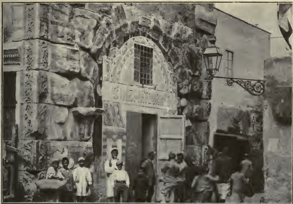
L'ARCO ALL'INIZIO DELLA CONQUISTA ITALIANA COI FORNICI CHIUSI DALLE PARETI DEL CINEMATOGRAFO COLLA PORTA A SUD.
