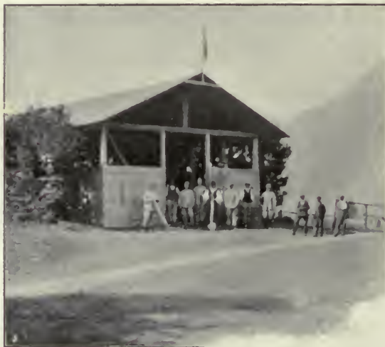
STABILIMENTO DI PIAIA (BELLUNO).
