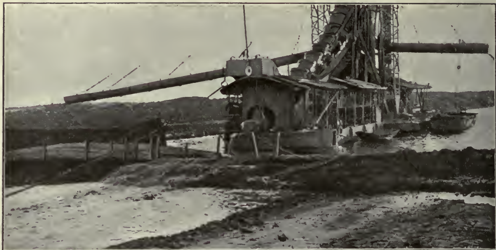
Ultimato lo scavo a mano di una successiva tratta di canale, la draga attacca la demolizione del diaframma di separazione. Le acque precipitano nel bacino inferiore.
