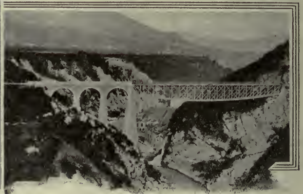
PONTE VIADOTTO SULL'ASTICO.
