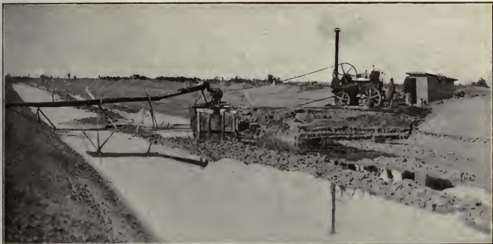
Le acque di infiltrazione e le forti piogge allagano il fondo dei bacini di scavo; si provvede all'esaurimento delle acque con pompe a vapore per permettere ai terraioli di riprendere il lavoro.
