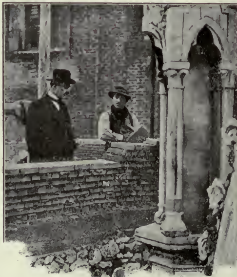
IL SOPRAINTENDENTE PER I MONUMENTI ING. ALESSANDRO DA LISCA SUI LAVORI.
