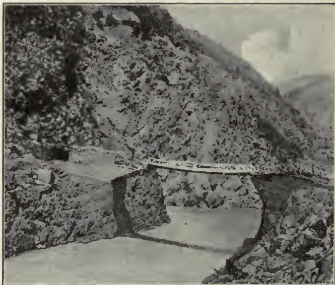
PONTE SULLA STRADA DI TREBISONDA NELLE MONTAGNE DI LAZISTAN.
