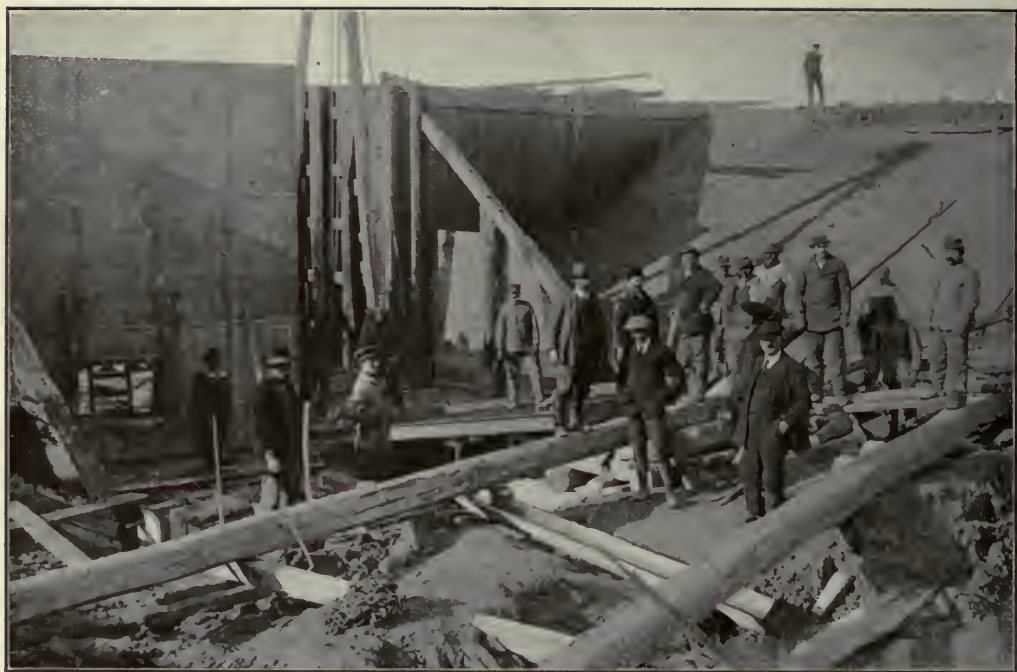
Si sollevano le porte in ferro di chiusura del bacino dei sostegni, e vengono messe in posto sui loro cardini.
