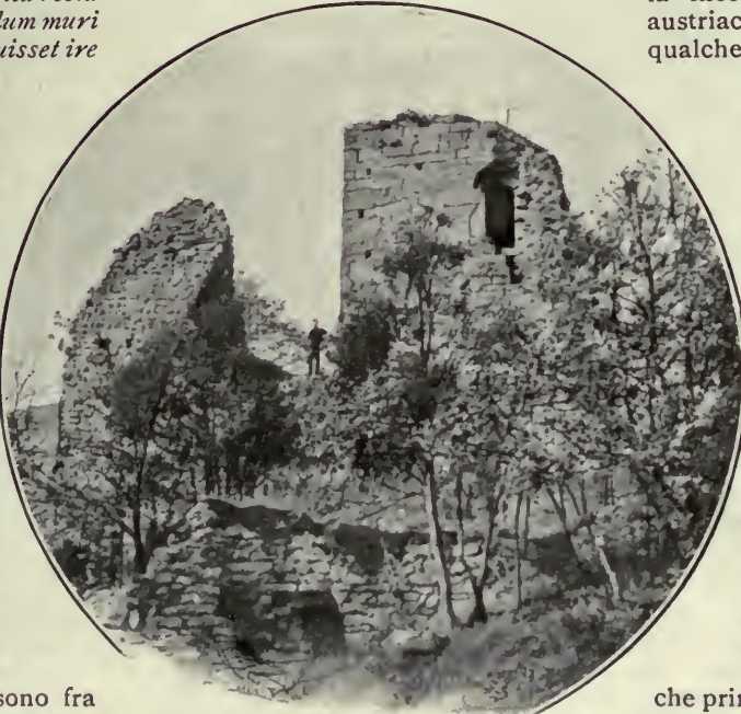
CASTELLO DI CASTELBARCO PRESSO CHIUSOLE (TRENTINO).
