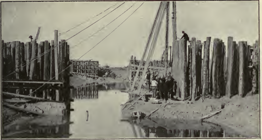
I sostegni a conca sulle due sponde del Tagliamento, lunghi 75 metri, sono costruiti in larname. Grossi pali di rovere infissi profondamente nel terreno, costituiscono l'ossatura principale degli spalloni delle porte dei sostegni.
