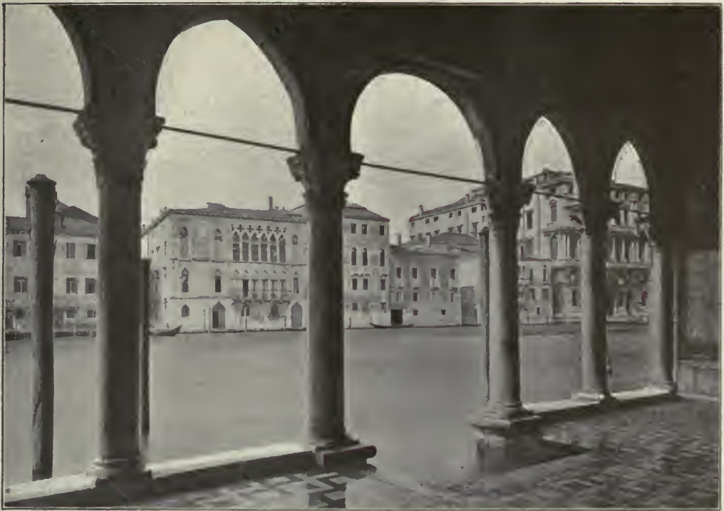
VENEZIA — LA CÀ D'ORO. IL PORTICO CON VEDUTA DEL CANAL GRANDE.
