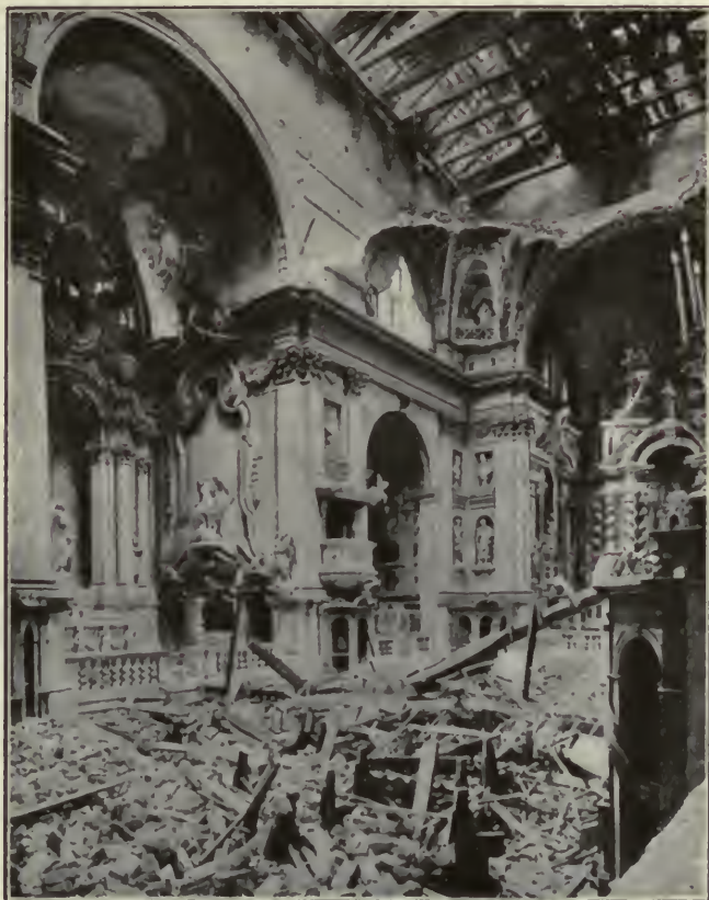
VENEZIA. — IL SOFFITTO DIPINTO DAL TIEPOLO AGLI SCALZI DISTRUTTO DA UNA BOMBA.
