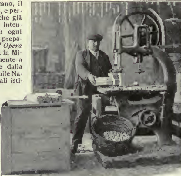
LE GROSSE SEGHE CIRCOLARI TAGLIANO MAGNIFICAMENTE TUTTO IL QUANTITATIVO DI ROTOLI CHE QUOTIDIANAMENTE OCCORRE.
