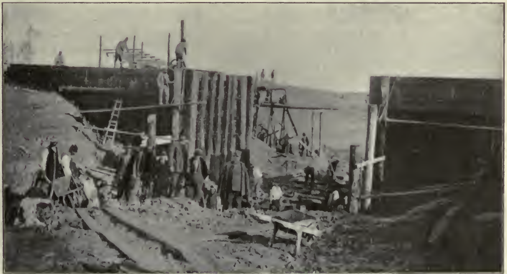
Le colonne di rovere sono collegate con saettoni, tiranti, lungarine. Sul perimetro di ogni spalla un doppio tavolato di grosse tavole di rovere o di larice, appuntite e profondamente infisse nel suolo, completa il manufatto, costituendo — per ciascuna spalla — un cassero stagno. L'interno del cassero è riempito di materie argillose compresse.
