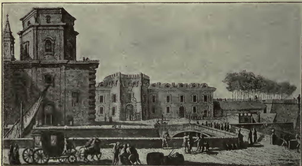
VEDUTA LATERALE DELLA CHIESA DI SANTA CATERINA DEI PP. DOMENICANI E DELLA PORTA SAN MARCO DI LIVORNO, ERETTA DA COSIMO III NEL 1703, DEMOLITA NEL 1802.
