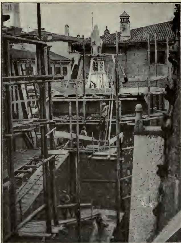
LE GROSSE ARMATURE INTORNO ALLE ARCHE.
