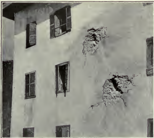
DUR FORI DI UN 105 AUSTRIACO IN UNA CASA CHE SI CREDEVA ABITATA DAL COMANDO.
