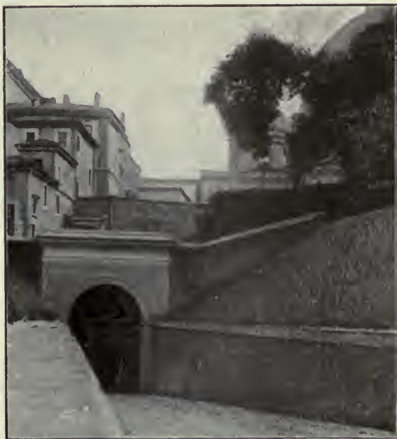
SBOCCO DELLA GALLERIA NEI GIARDINI.
