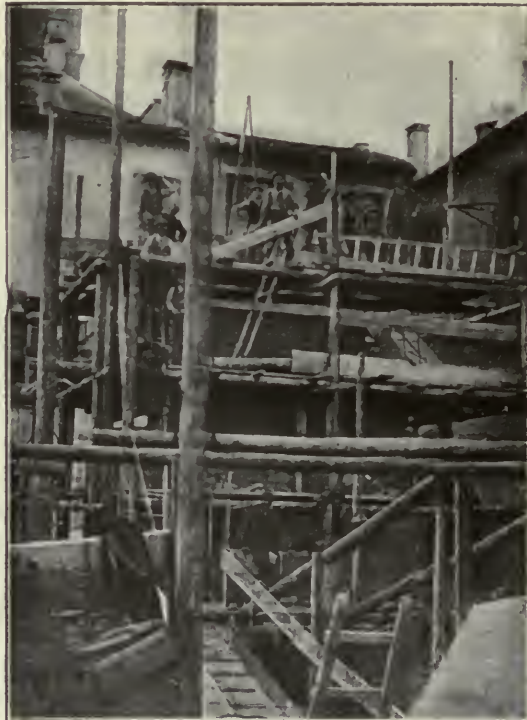
VERONA. — ARCHE SCALIGERE LAVORI DI PROTEZIONE.
