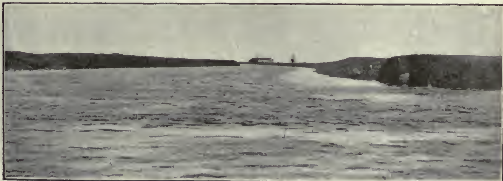
Abbattuto il diaframma di separazione con la laguna di Caorle, la prima tratta del canale di destra viene invasa dalle acque.
